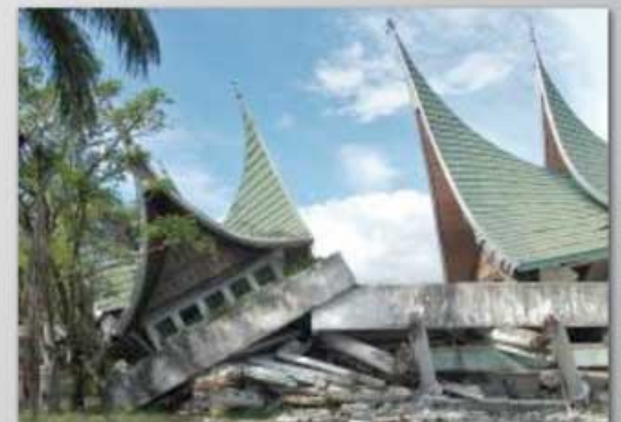
Kerusakan Bangunan karena Gempa 2009
